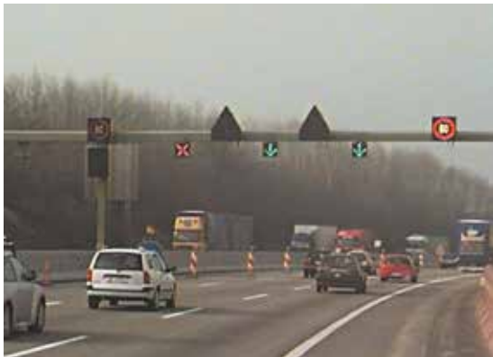
Signalisationsquerschnitt mit Geschwindigkeitsanzeige und Fahrstreifenlichtsignale
