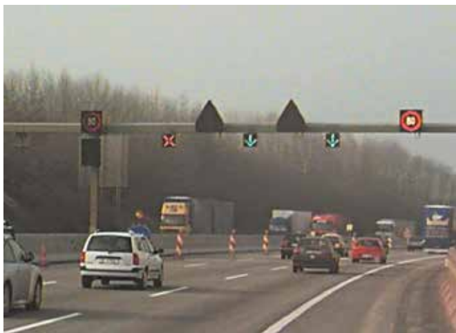
Signalisationsquerschnitt mit Geschwindigkeitsanzeige und Fahrstreifenlichtsignale
