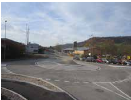
Netzenkreisel Blickrichtung Tiefbauamt BL Kreis 3 / NWNW
