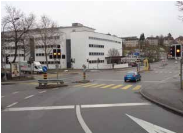
Situation Knoten vor Sanierung (LSA)
