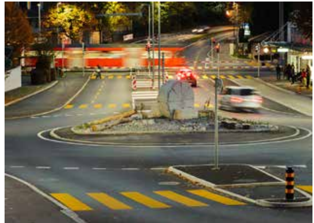
Situation Knoten nach Sanierung (Kreis)
