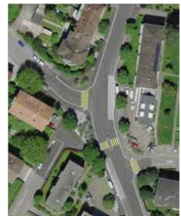
Knoten nach dem Umbau mit Schwammstadtelementen
