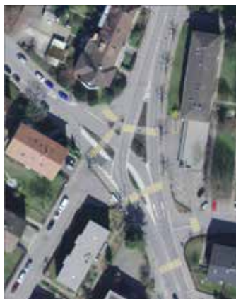
Knoten vor dem Umbau
