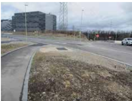
Echter Bypass Seite Krummeneichstrasse
