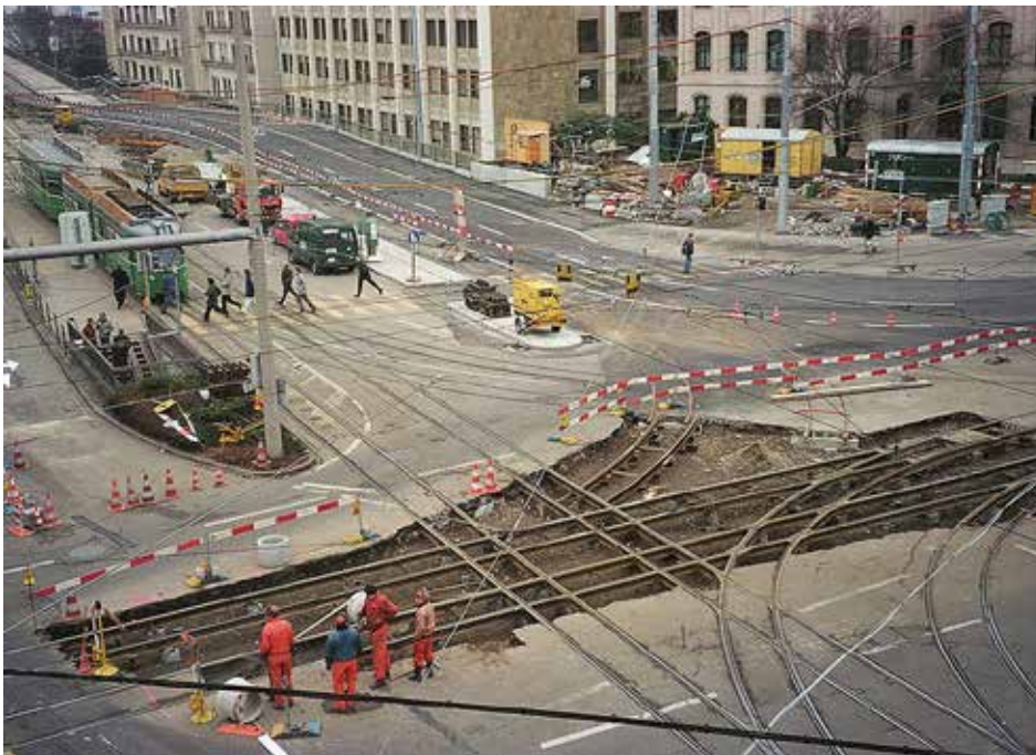
Umbau Gleisarbeiten Knoten Dreirosen2. Bauphase
