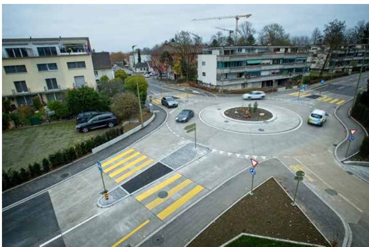
Kreisel Grabenring / Hegenheimermattweg mit Betonoberfläche
