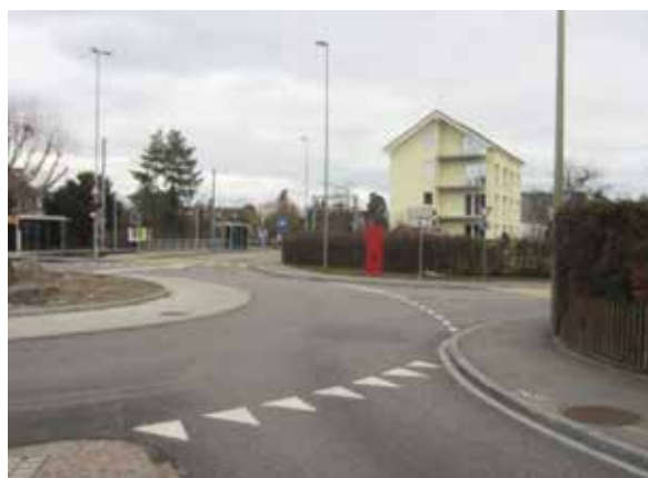
Ansicht erhöhter Betoninnenring
