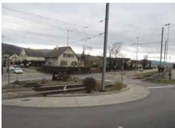
Betoninnenring mit neuem Deckbelag
