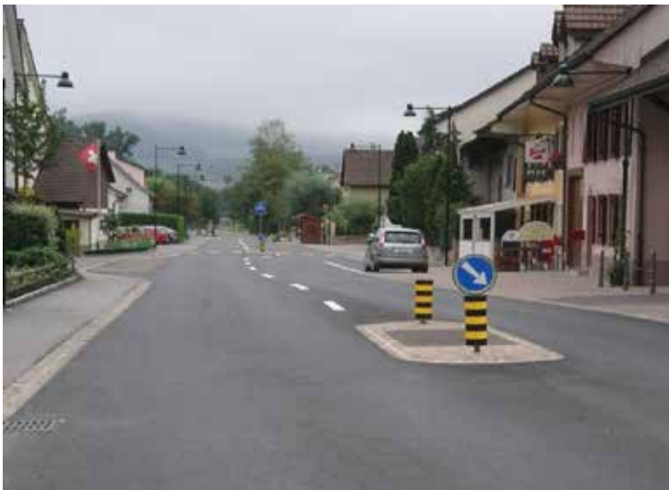
Hauptstrasse Tecknau nach der Umgestaltung
