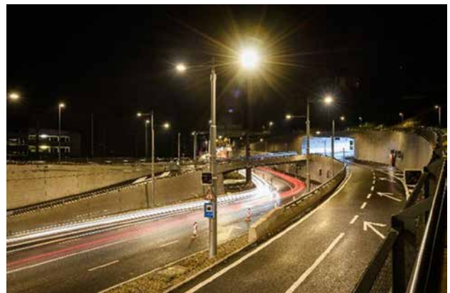
Tunnelportal Vorzone Bahntal
