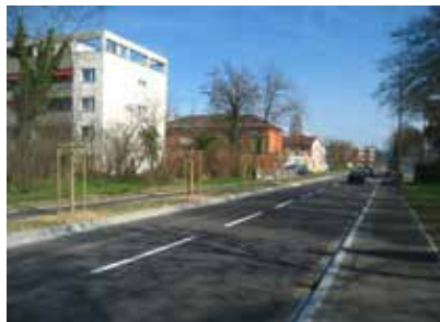
Prattelerstrasse; Strassenquerschnitt mit beidseitigem Gehweg und einseitiger, neuer Baumrabatte
