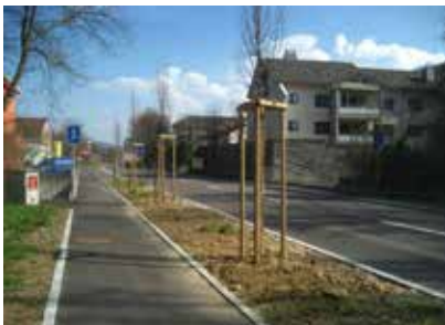
Prattelerstrasse; Strassenquerschnitt mit beidseitigem Gehweg und einseitiger, neuer Baumrabatte
