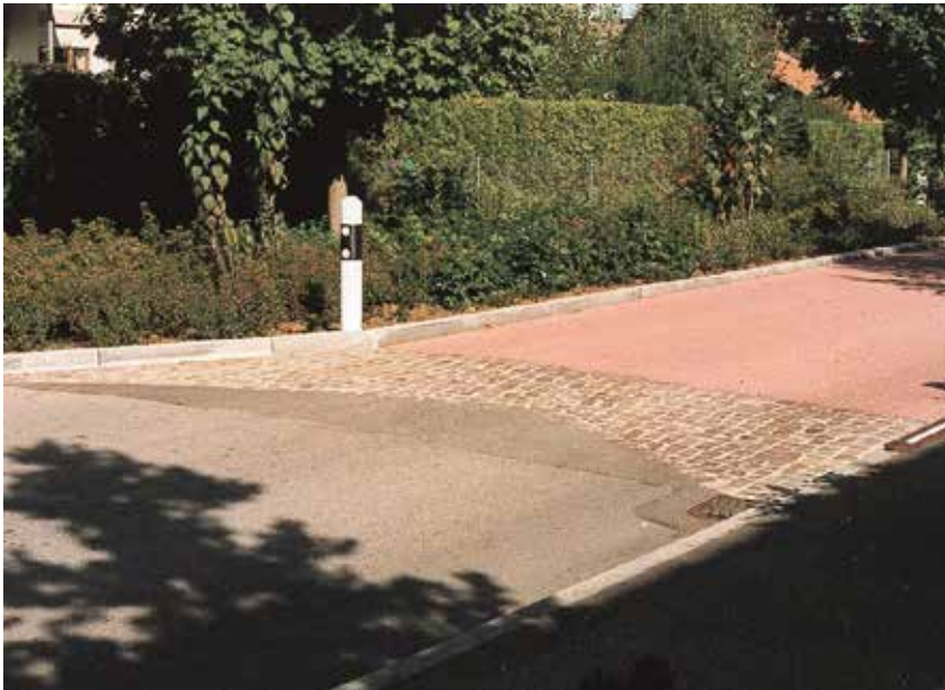
Aufpflasterung mit Schmetterlingsform
