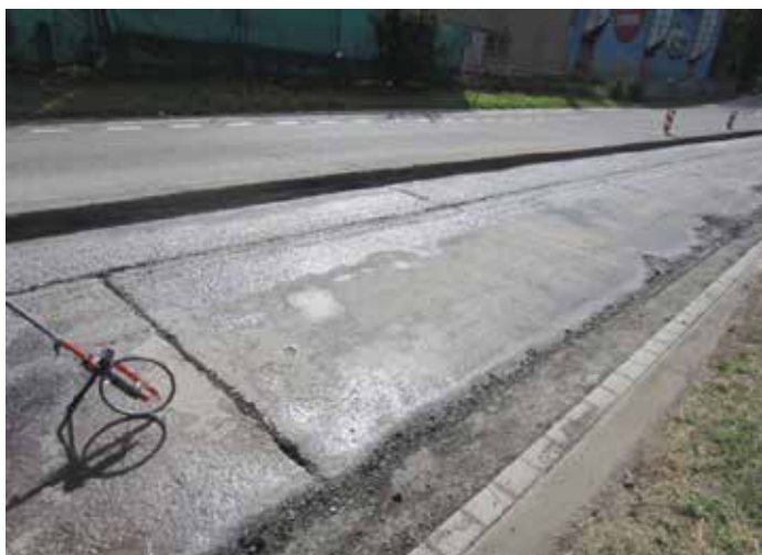
Freigelegte Betonfahrbahn zur Aufbringung SAMI
