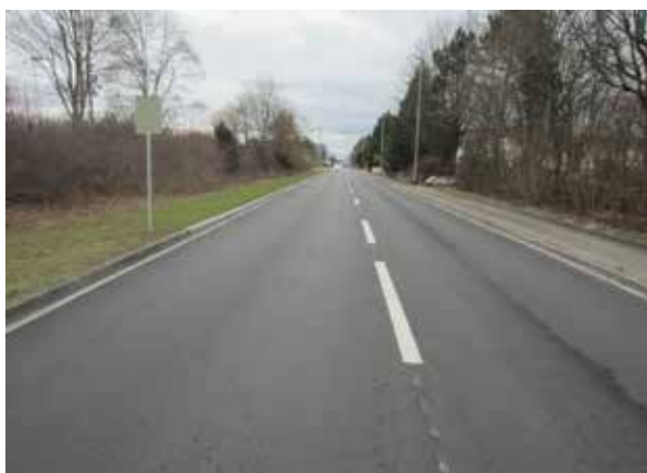
Belagserneuerung Pfeffingerring (lärmarmen Deckbelag)
