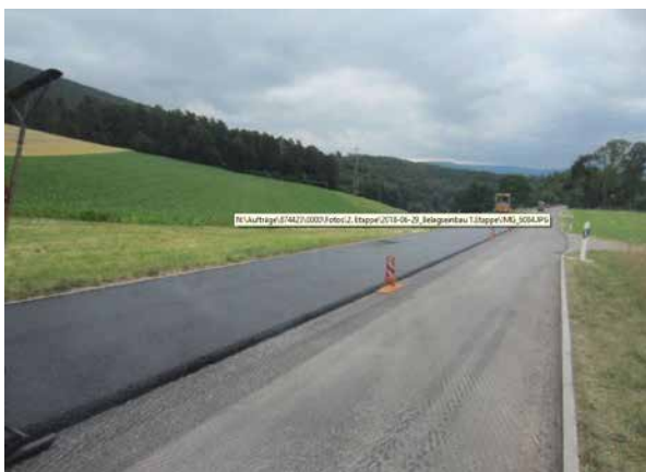
gefräste & gereinigte Oberfläche (rechter Fahrstreifen) Walzarbeiten nach Belagseinbau (linker Fahrstreifen)
