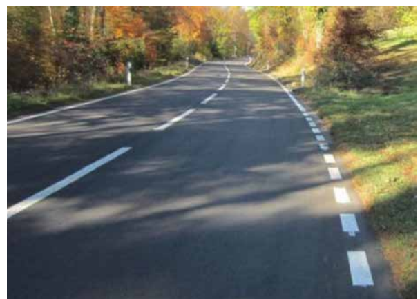
Fertiggestellte Challstrasse 2. Etappe mit neuer Markierung nach der Belagssanierung
