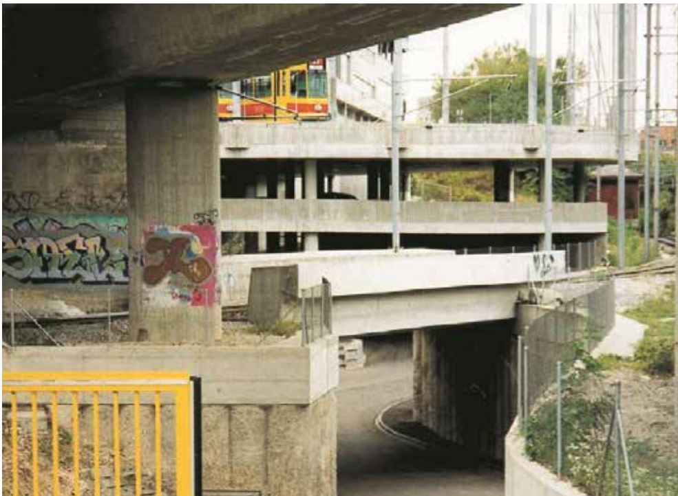
Entflechtung auf verschiedenen Ebenen (Arealerschliessung, Bahn, Tram)
