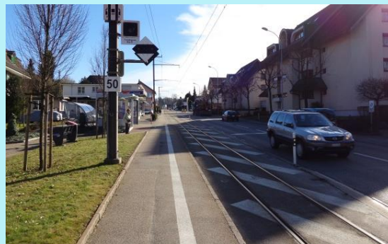
Heute: Strasse mit Eigentrasse asm und ohne Radstreifen. Grosse Trennwirkung und Sicherheitsdefizite.
