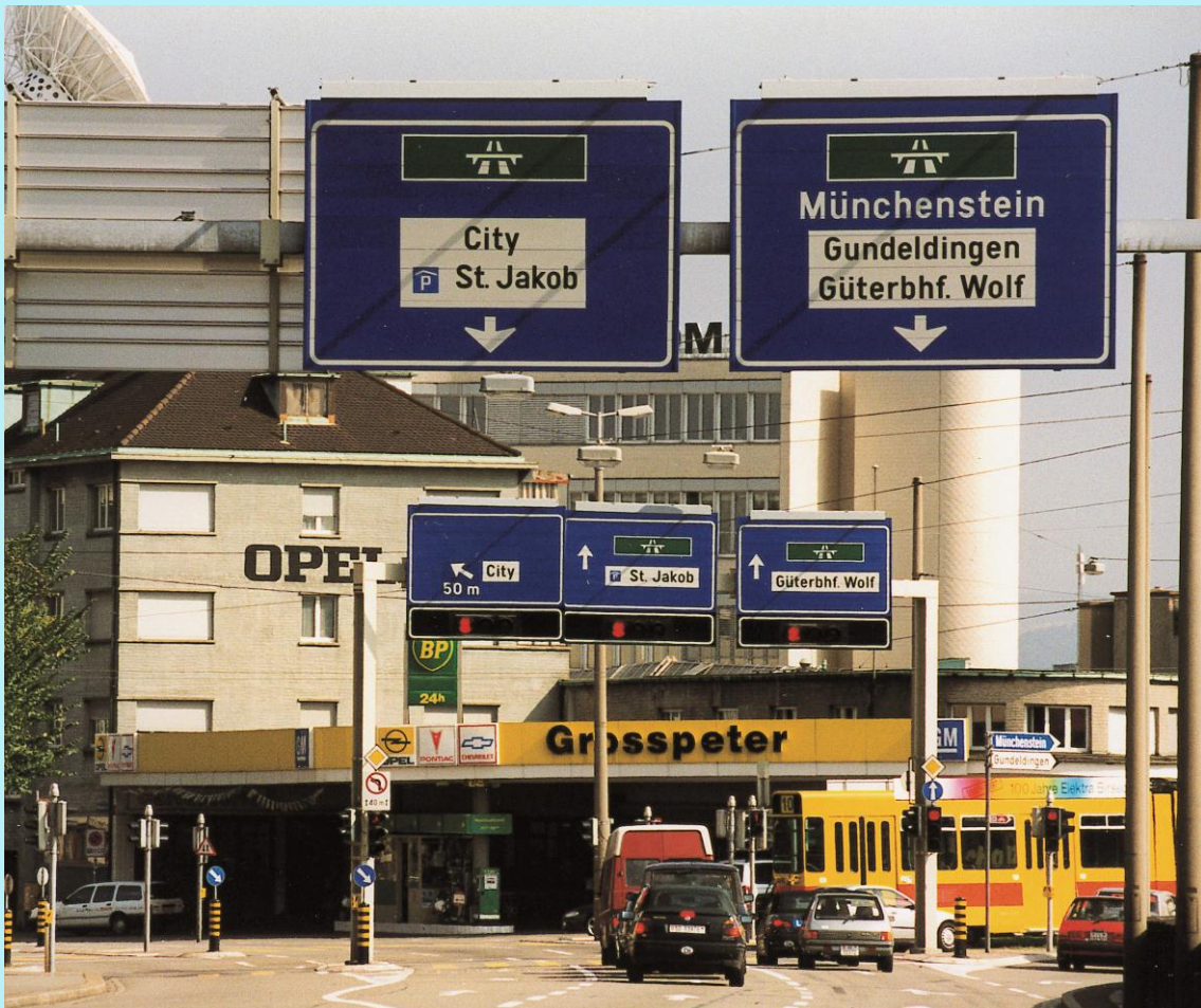
Überkopfsignale mit LSA und Markierung beim Knoten Grosspeter
