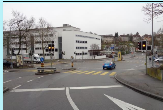
Situation Knoten vor Sanierung (LSA)
