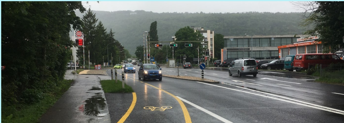
Umgestalteter LSA-gesteuerter Knoten mit Bahnübergang und Langsamverkehrsquerung
