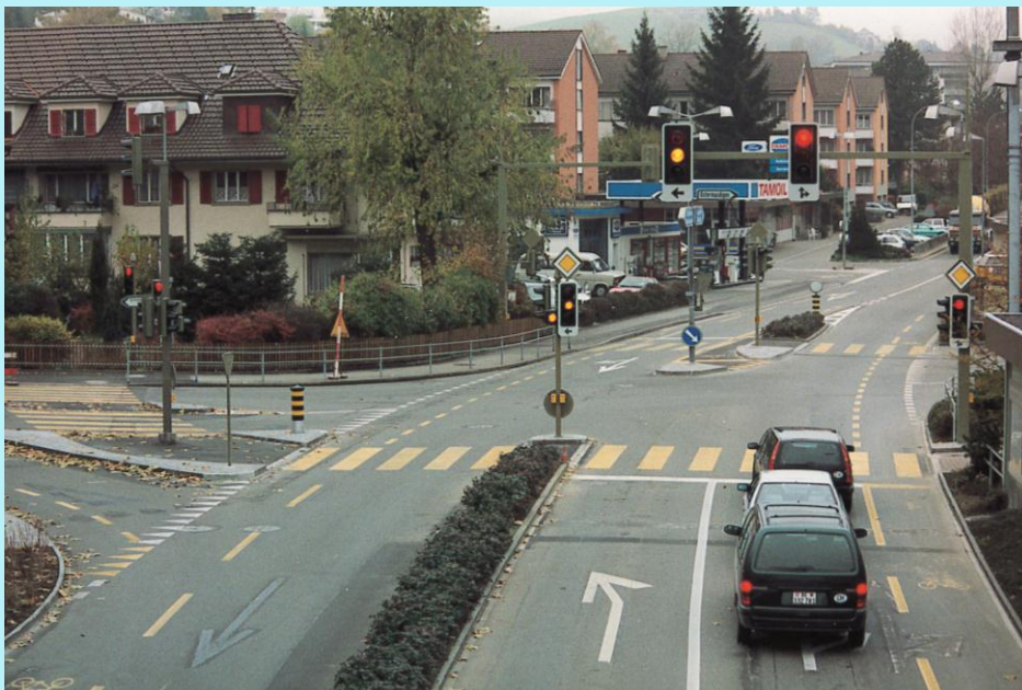
Knoten Worbental- strasse/Zollgasse (Ittigen BE) nach der Sanierung
