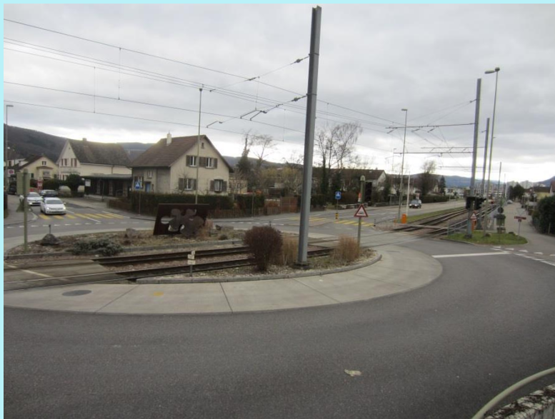
Betoninnenring mit neuem Deckbelag
