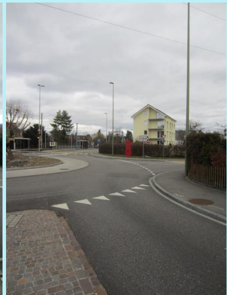
Ansicht erhöhter Betoninnenring
