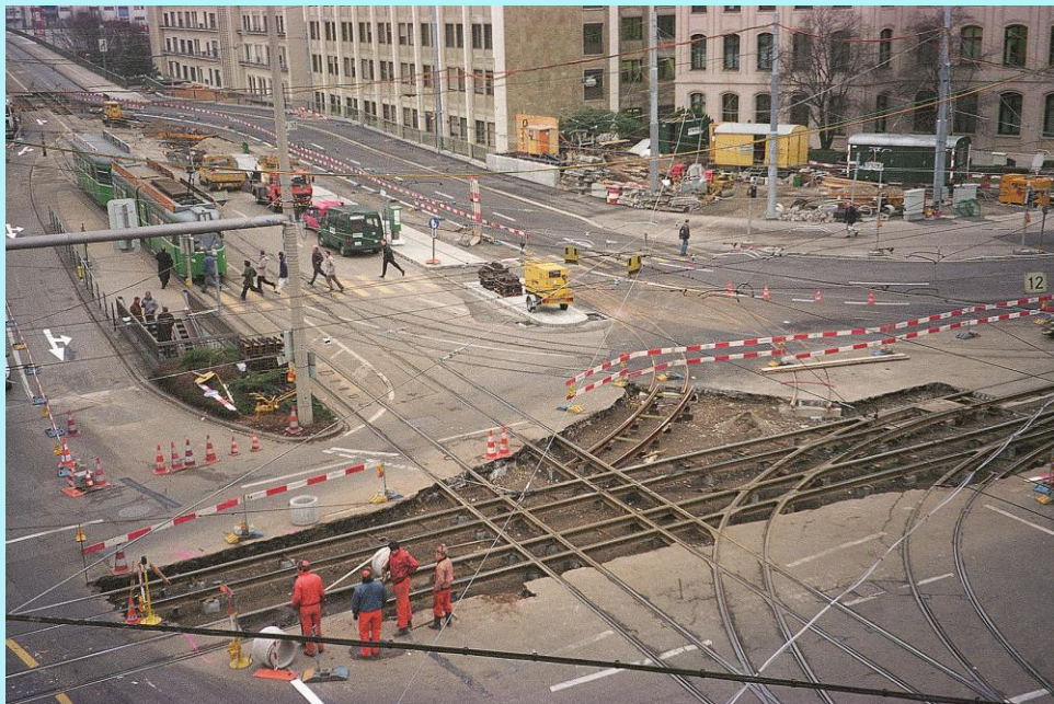
Umbau Gleisarbeiten Knoten Dreirosen 2. Bauphase
