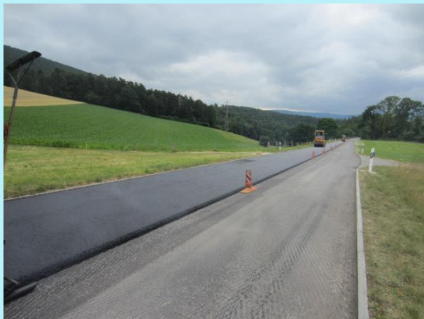
gefräste & gereinigte Oberfläche (rechter Fahrstreifen) Walzarbeiten nach Belageinbau (linker Fahrstreifen)
