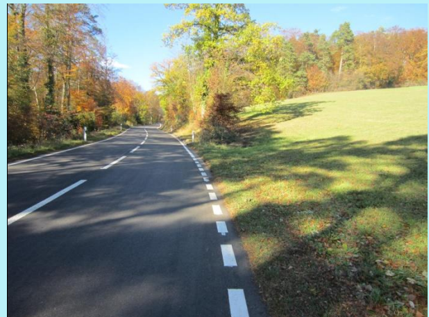
Fertiggestellte Challstrasse 2. Etappe mit neuer Markierung nach der Belagssanierung
