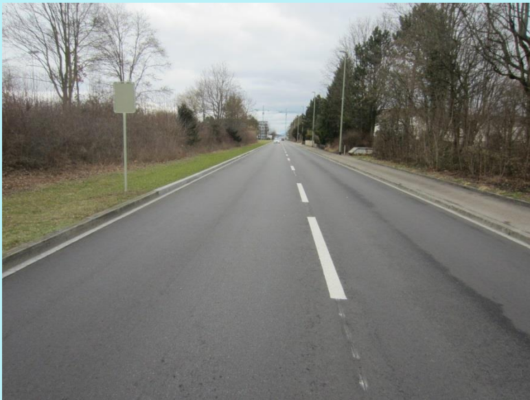
Belagserneuerung Pfeffingerring (lärmarmen Deckbelag)
