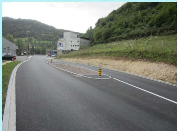
Eingangstor im Bereich Ortseinfahrt Grellingen
