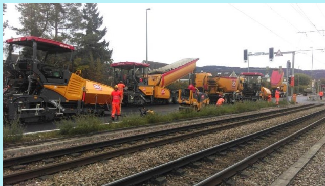
Einbau Deckbelag Bereich Fichtenweg
