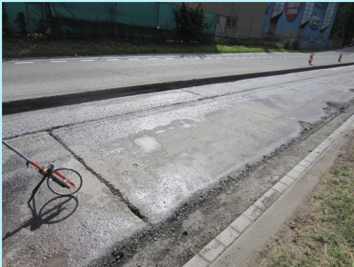
Freigelegte Betonfahrbahn zur Aufbringung SAMI
